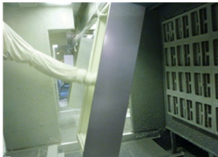
Mauser Einrichtungssysteme beschichtet sein Teile Spektrum u.a. in zwei Roboterlackierkabinen. Mit der Druckluftaufbereitung wird bei komplexen Geometrien eine bessere Eindringtiefe in Ecken und Kanten erzielt.
