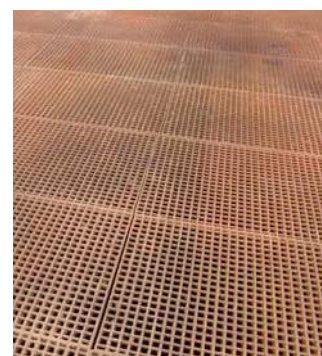
Standzeit 15 Monate – Nach Abreinigung der Gitterroste
