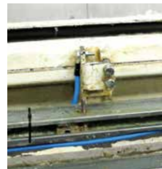
1 Anschluss der Funktionserdung an die Lackierkabine
