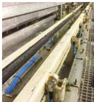
2 Verkabelung zum Erdungsschrank
