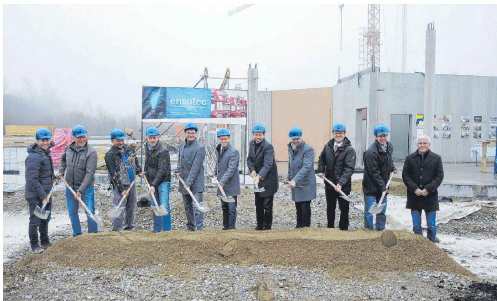
Symbolischer Spatenstich zum Neubau der Montage- und Produktionshalle von Ensutec in Andelfingen mit Peter Löffler (von links), Lothar Pallaske und Marc Korschus von der Firma Löffler, Projektleiter Edgar Ocker, Bauherr Thomas Mayer, Bürgermeister Andreas Schneider, Landtagsabgeordneter Thomas Dörflinger, Bernd Schwarzenborfer vom Landratsamt Biberach, Reiner Reck von der Kreissparkasse Riedlingen, Ortsvorsteher Edgar Springer und Projektleiter Mike Seibold.
