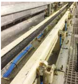
2 Verkabelung zum Erdungsschrank
