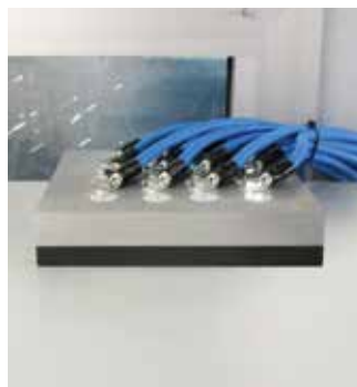
3 Anschluss am Erdungsschrank
