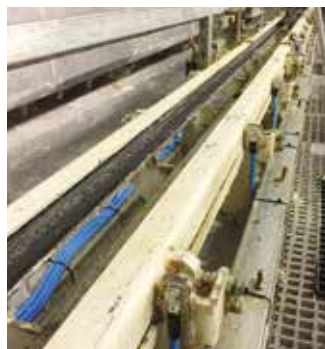
2 Câblage de la mise à la terre fonctionnelle
