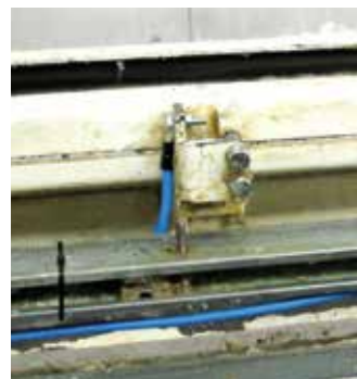
1 Connexion du système de mise à la terre fonctionnelle en cabine de peinture
